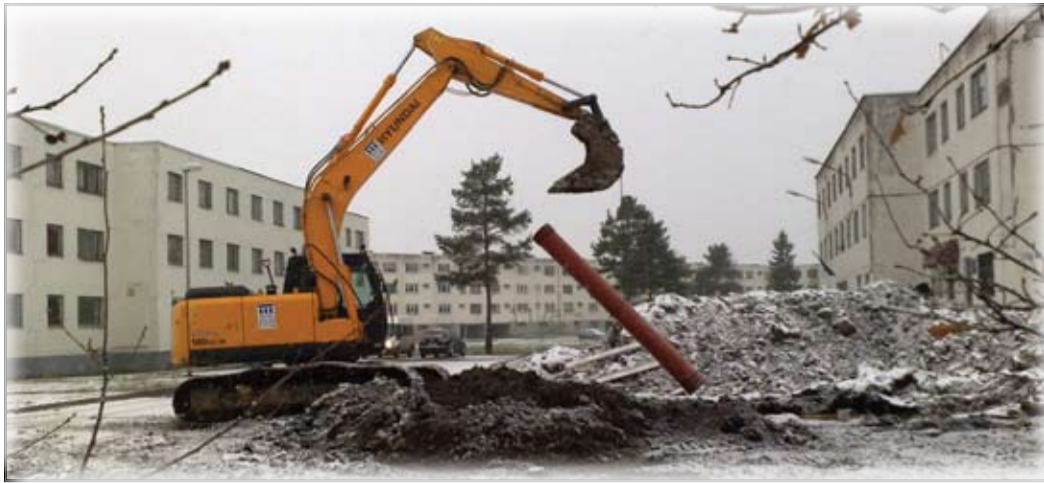
Строительные работы в Пюсси должны завершиться к Рождеству. Восстановительные работы будут сдвинуты на следующий год.
